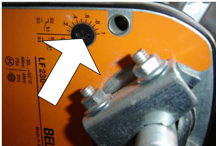
Obr. č. 6 Nastavení vačky na pohonu uzavírací klapky
